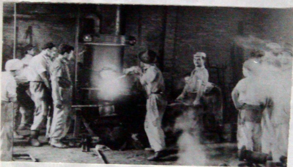
Ao lado: Técnicos e auxiliares, em trabalho na fundição de ferro.
