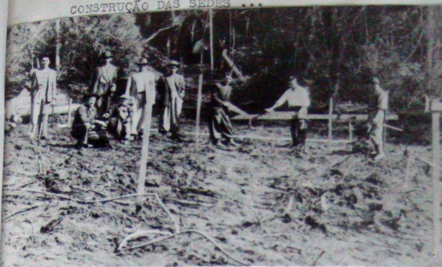
Início da construção de uma residência de agricultor em plêna selva.
