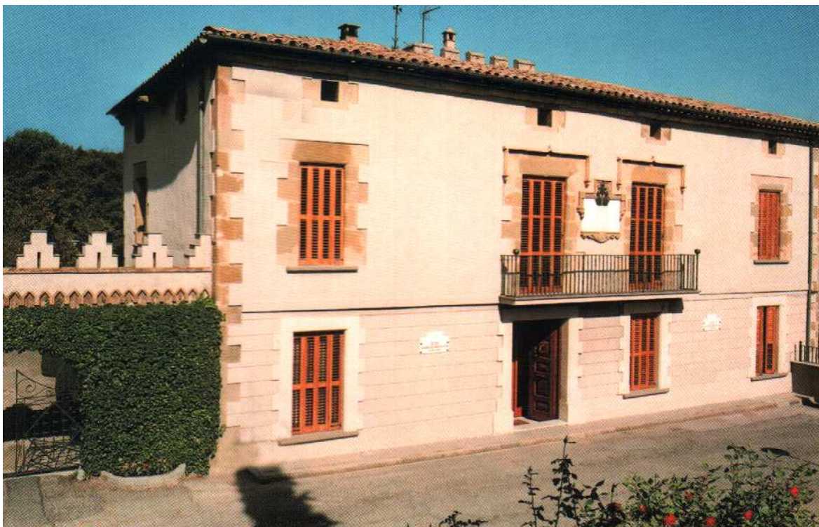
Figura 3: Manso Escorial – berço da Congregação (Vich – Espanha – 2007) Fonte: Colégio Santa Cruz.
