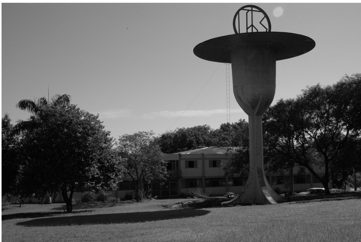
Caixa d'água do Seminário Maior Arquidiocesano Nossa Senhora da Glória – Maringá - 2006 (Acervo do Seminário)
